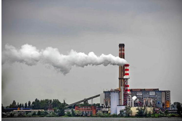
3. kép: a Vértesi Erőmű
