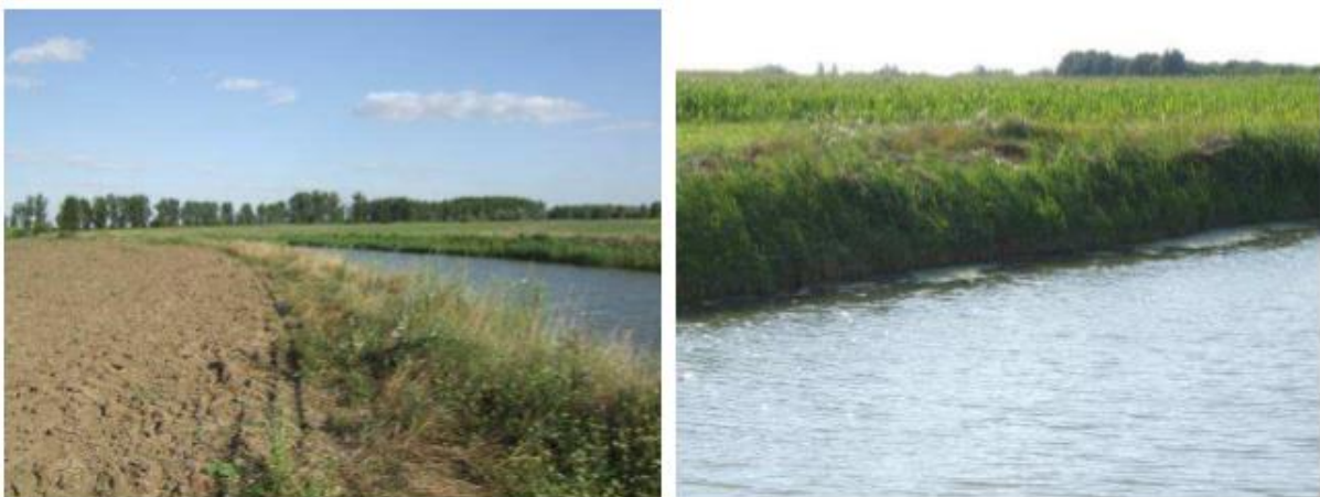
8. ábra: Dögös-Kákafoki csatorna a tervezett műtárgy helyszínén (Fodor, 2012: 9)
