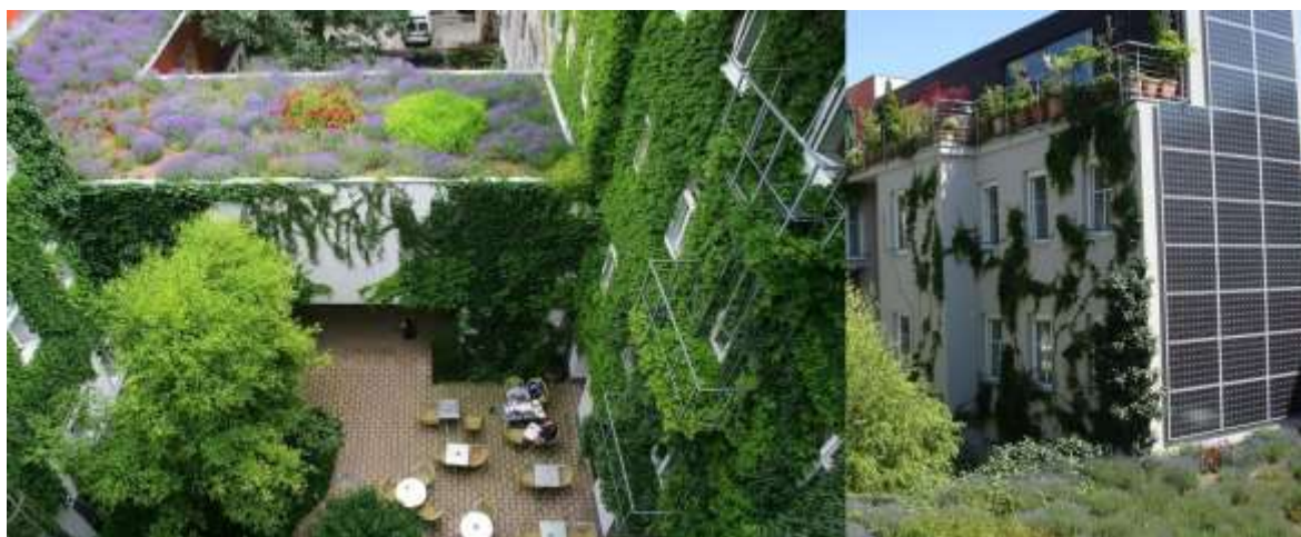
7. ábra A zöld innováció nulla energiás példája Bécs belvárosától 8 perces sétára, a Boutiquehotel Stadthalle üdítő városi szigete ( https://www.schindler.com és https://de.wikipedia.org/ )
